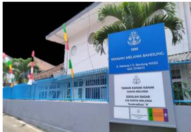
Tampak depan bangunan
